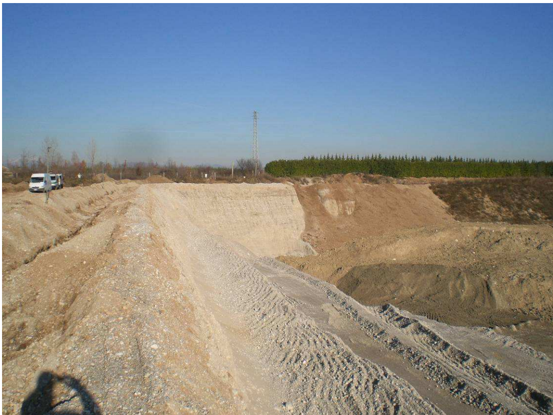
FOTO 6 - verso Nord (area in escavazione)
