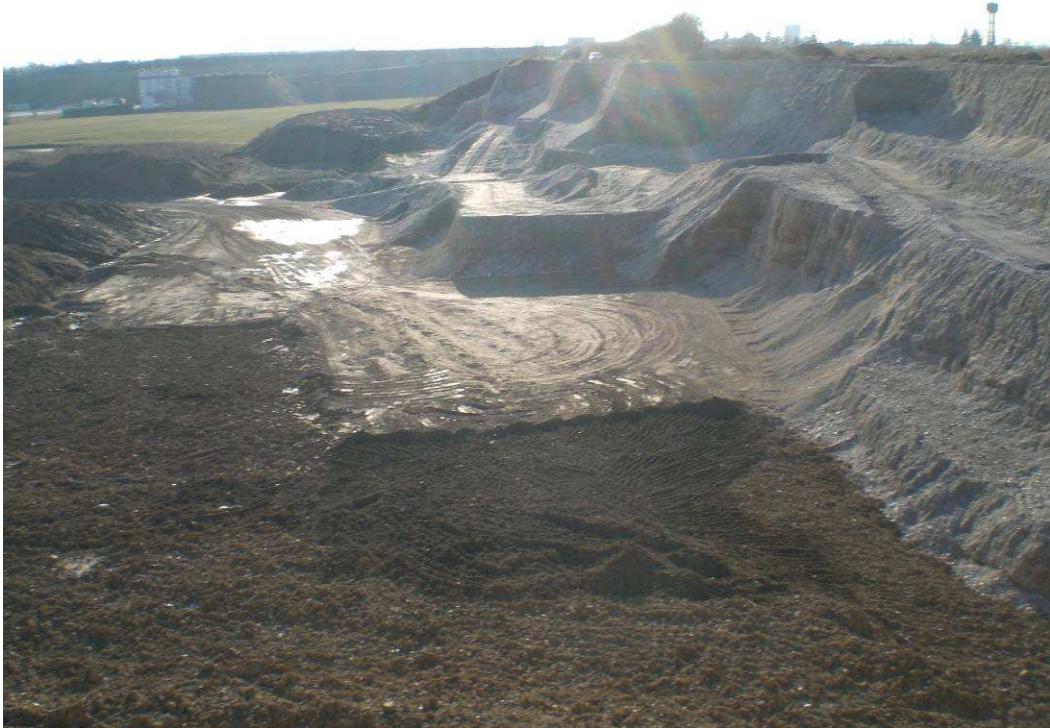
FOTO 5 - verso Sud (area in escavazione)
