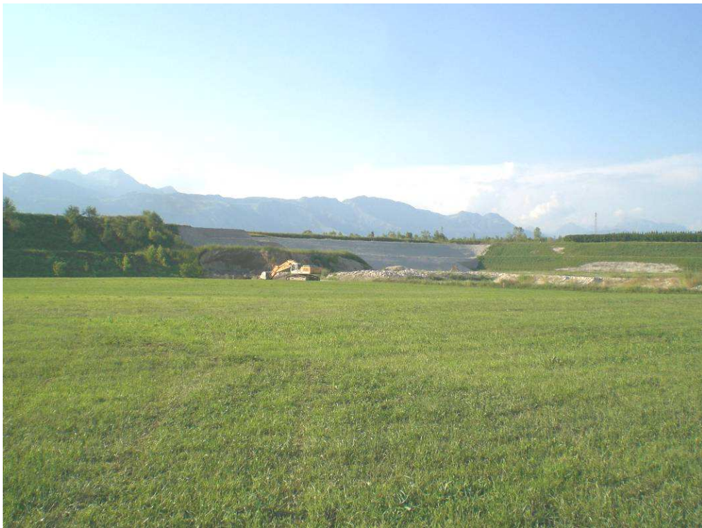
FOTO 4 - verso Nord-Ovest (area in escavazione)
