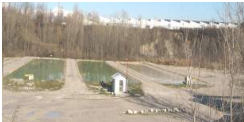
Ripresa del dicembre 2010. Il piano di imposta delle vasche di decantazione dei limi coincide con il fondo di progetto.
